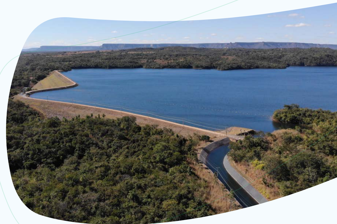
Santa Cruz Power Corporation Usinas Hidroelétricas S.A. - São Domingos | GO
