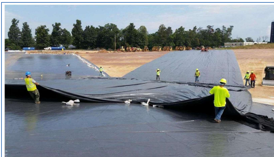
FIGURA 7 - EXEMPLO DA INSTALAÇÃO DOS PAINÉIS DA GEOMEMBRANA REFORÇADA
