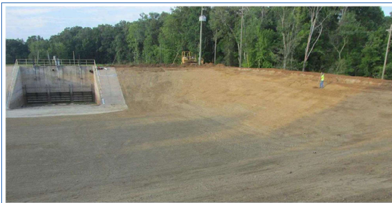
FIGURA 6 - EXEMPLO DE SUPERFÍCIE REGULARIZADA, APTA PARA O RECEBIMENTO DA GEOMEMBRANA REFORÇADA
