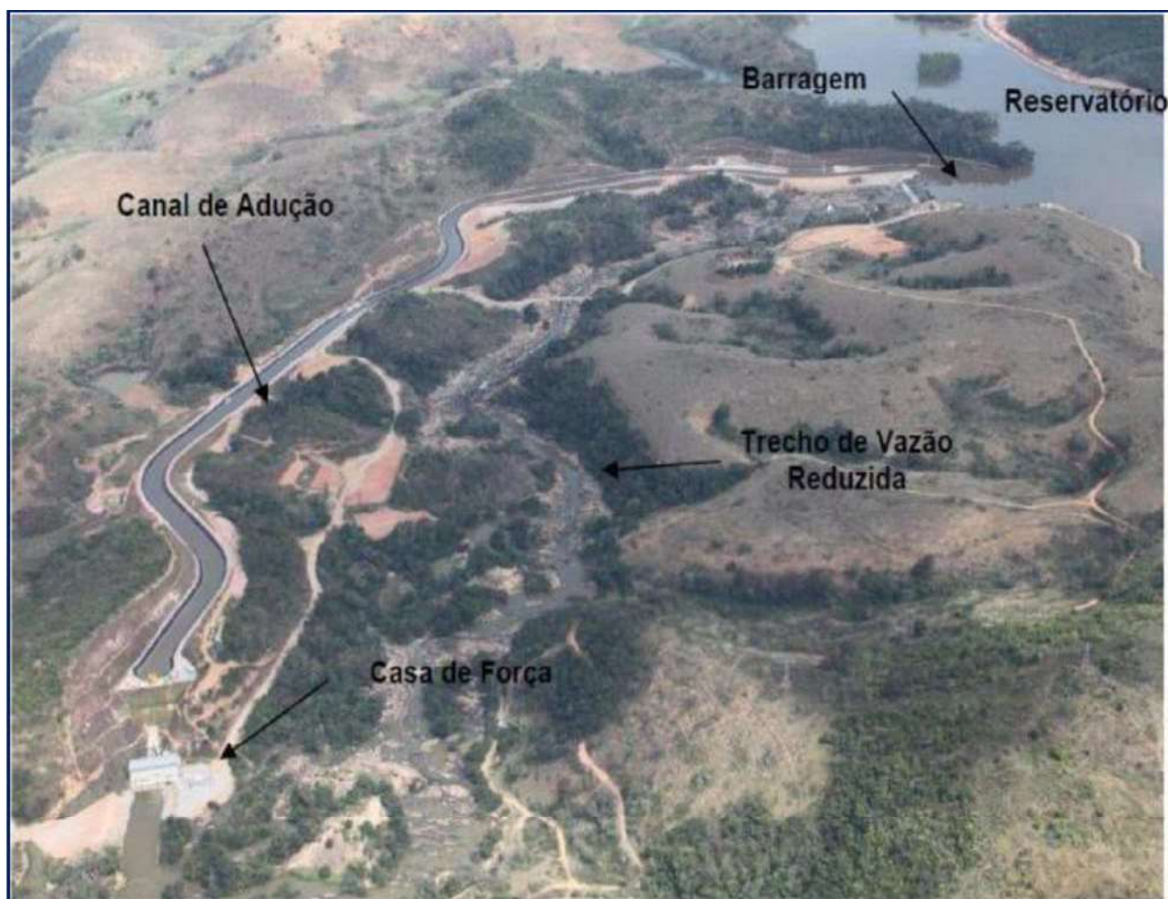
Figura 2: Entre as estruturas existente da PCH Pedra do Garrafão
