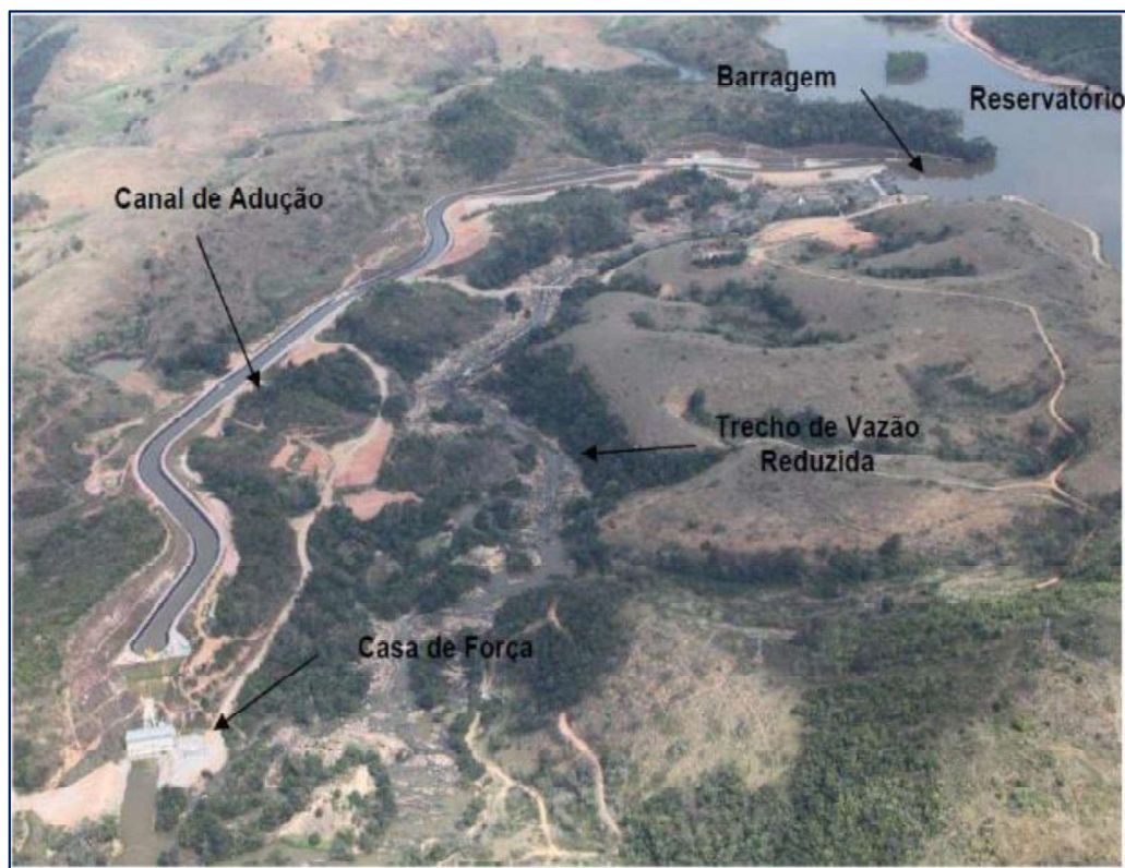
FIGURA 2 ESTRUTURAS DA PCH PEDRA DO GARRAFÃO
