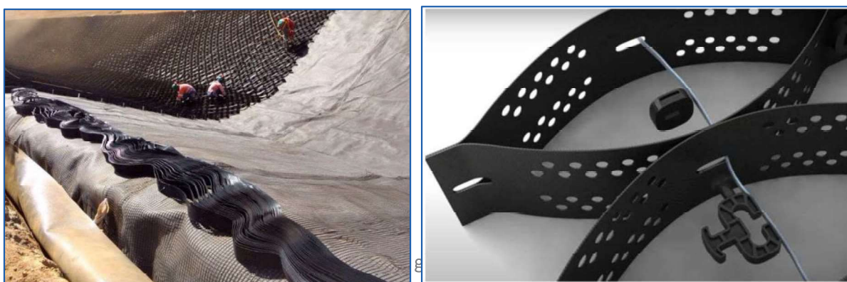
FIGURA 8 – ILUSTRAÇÃO DAS GEOCÉLULAS – À ESQUERDA: GEOCÉLULAS SENDO APLICADA; À DIREITA: CONFIGURAÇÃO TÍPICA DE UMA GEOCÉLULA
