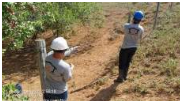
Foto 03 Manutenção setor 2 na PCH Pedra do Garrafão.
