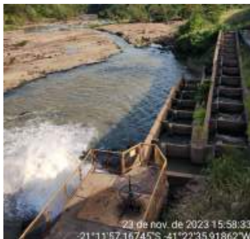
Foto 09 Sistema de Transposição de Peixes (STP ou “escada de peixes”).
