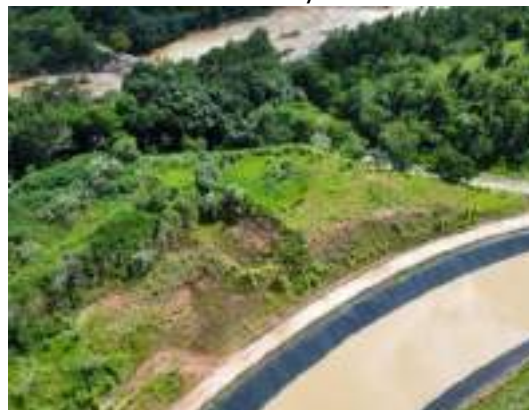
Foto 73 Visão geral do ponto PGF05 na PCH Pedra do Garrafão - dezembro/2024
