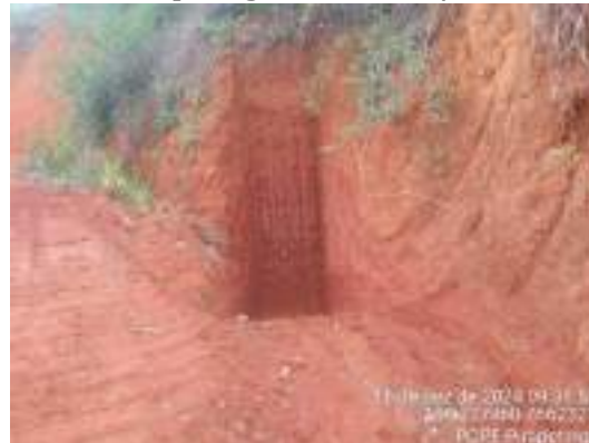
Foto 55 Visão geral das caixas de contenção instaladas no acesso da chaminé de equilíbrio da PCH Pirapetinga – dezembro/2024.
