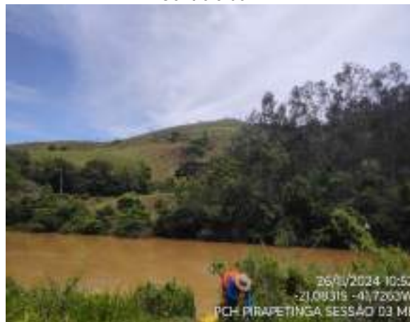
Registro fotográfico 3-14 – Vista da Seção de Controle 03.
