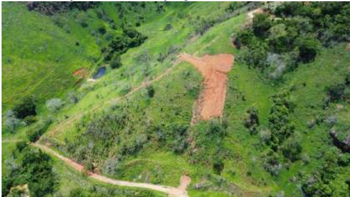
Foto 09 Visão Geral do ponto PIR29 na PCH Pirapetinga em dezembro de 2024
