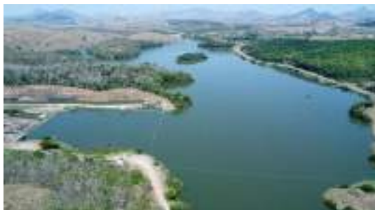
Foto 52 Visão geral do reservatório da PCH Pedra do Garrafão (Set/24).
