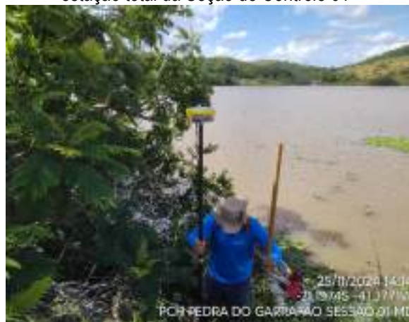
Registro fotográfico 3-2 – Levantamento com estação total da Seção de Controle 01
