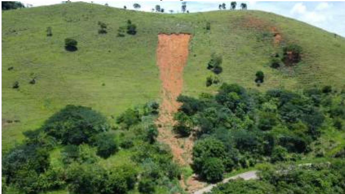
Foto 08 Visão Geral do ponto PIR28 na PCH Pirapetinga em dezembro de 2024
