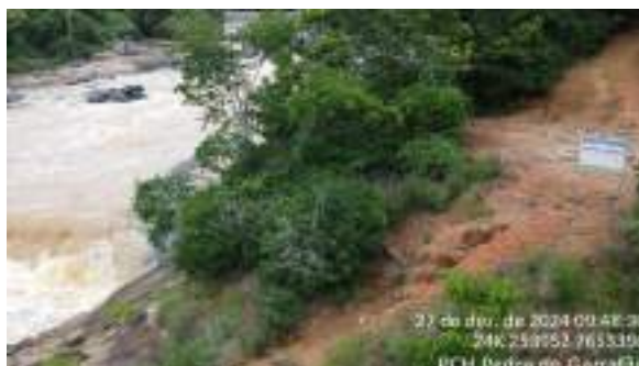
Foto 93 Nova placa de sinalização instalada no TVR da PCH Pedra do Garrafão.
