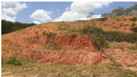
Foto 96 Visão geral do ponto PGF16 na PCH Pedra do Garrafão em 2019.
