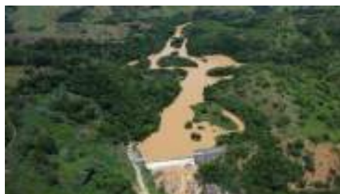
Foto 19 Visão geral do reservatório da PCH Pirapetinga em dezembro/2024.
