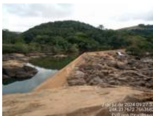
Foto 57 Visão geral da soleira vertente na PCH Pirapetinga (Jul/24)
