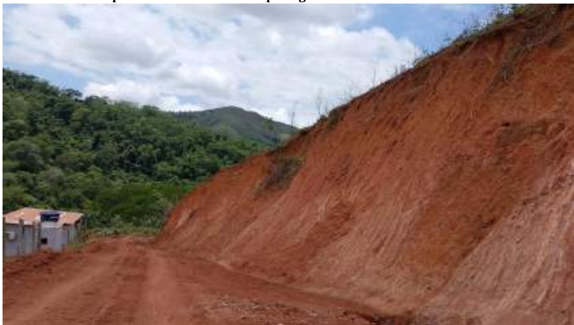
Foto 04 Visão Geral do ponto PIR24 na PCH Pirapetinga em dezembro de 2024
