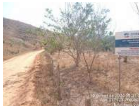
Foto 62 Vistoria no cercamento do setor 5 da PCH Pirapetinga. (set/24).
