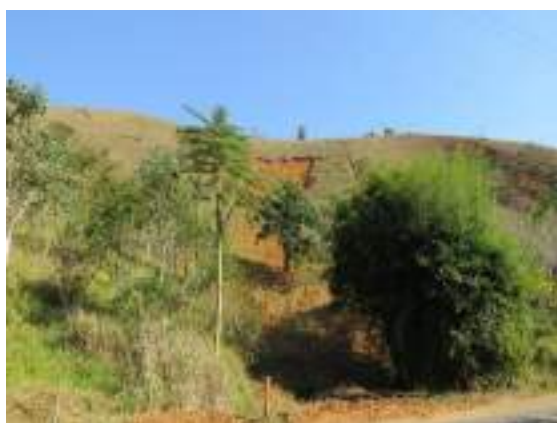
Foto 82 Deslizamento da encosta na pastagem a montante, atingindo a Área 1 - Setor 4 em recuperação.
