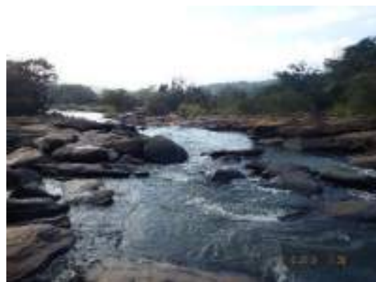
Foto 32 Vista parcial, área Trecho de Vazão Reduzida 2, PCH Pedra do Garrafão.
