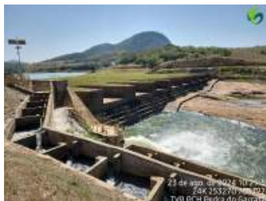
Foto 71 Visão geral da barragem, vazão sanitária e escada de peixe na PCH Pedra do Garrafão (Ago/2024).
