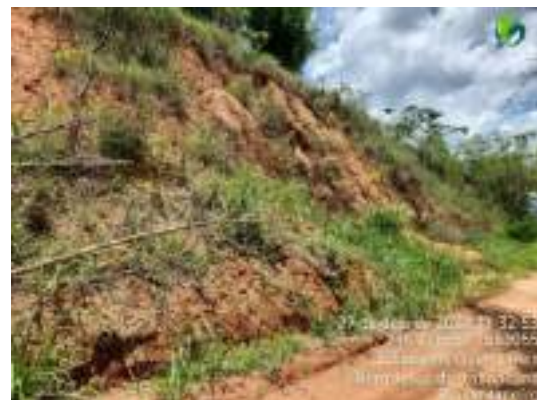
Foto 41 Visão geral do Ponto PIR11 na margem da estrada municipal Quincas Reis na PCH Pirapetinga – dezembro 2024.
