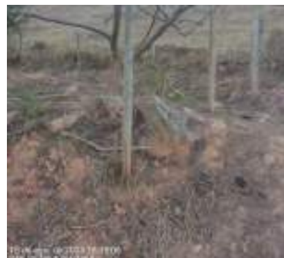
Foto 13 Manutenção do cercamento no setor 5 da PCH Pirapetinga em agosto de 2024.
