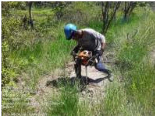
Foto 21 Coveamento no setor 1A na PCH Pedra Garrafão.
