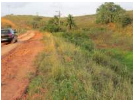
Foto 80 Visão geral do ponto PGF12 na PCH Pedra do Garrafão - 2018.
