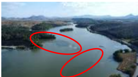
Foto 50 Visão geral do reservatório da PCH Pedra do Garrafão com início de formação de banco de macrófitas (Jul/24).
