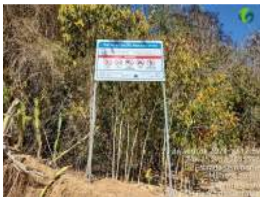
Foto 88 Nova placa de sinalização instalada no TVR da PCH Pedra do Garrafão.
