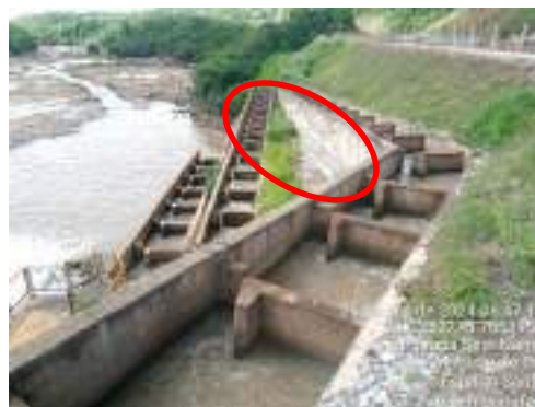
Foto 91 Escada de peixe da PCH Pedra do Garrafão após manutenção.
