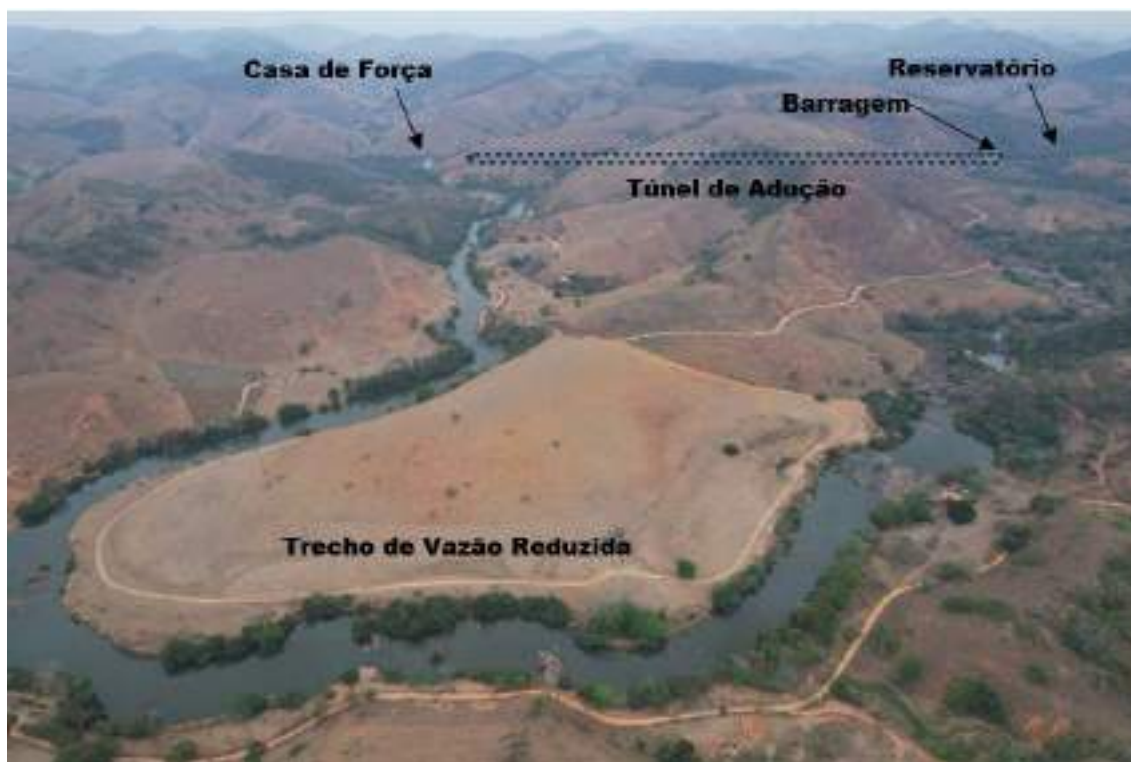
Figura 02 Imagem aérea da PCH Pirapetinga
