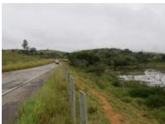
Foto 66 Visão geral do ponto PGF01 na PCH Pedra do Garrafão – 2018.
