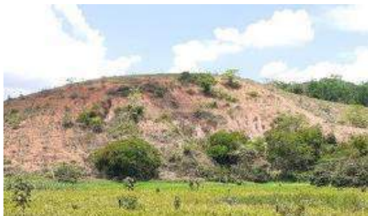
Foto 94 Visão geral do ponto PGF14 na PCH Pedra do Garrafão em 2019.
