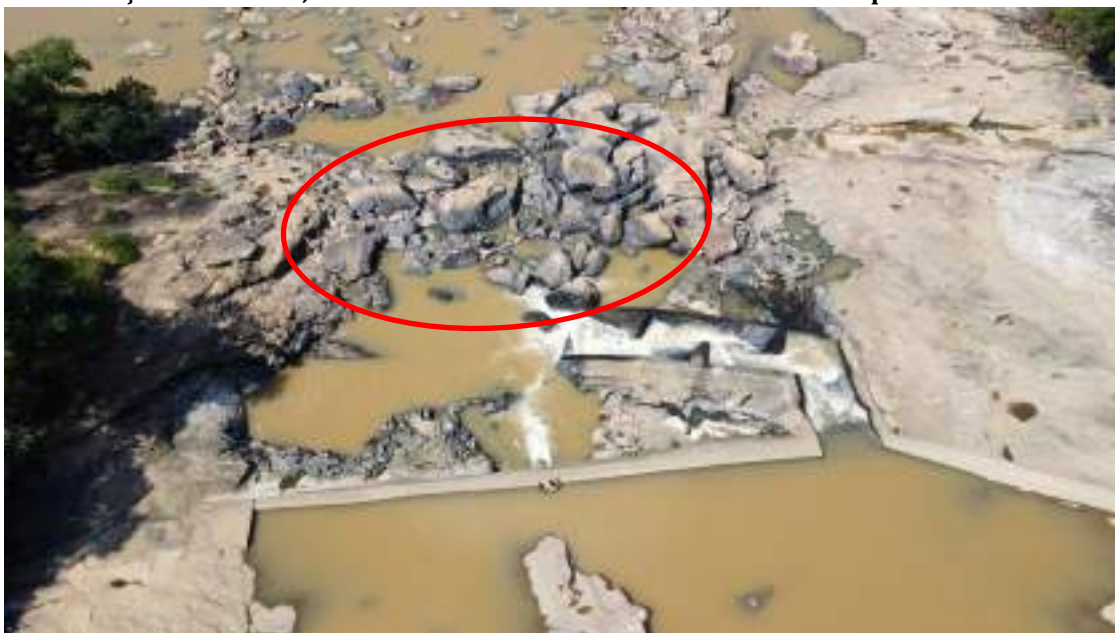
Foto 96 Região a jusante da soleira 1 no TVR da PCH Pedra do Garrafão, com o trecho obstruído pela movimentação das rochas, dificultando o deslocamento da ictiofauna no período de baixa vazão.
