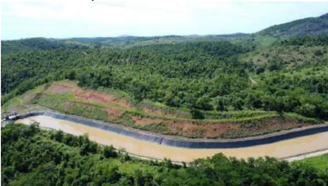
Foto 89 Visão Geral do ponto PIR17D na PCH Pedra do Garrafão em dezembro de 2024
