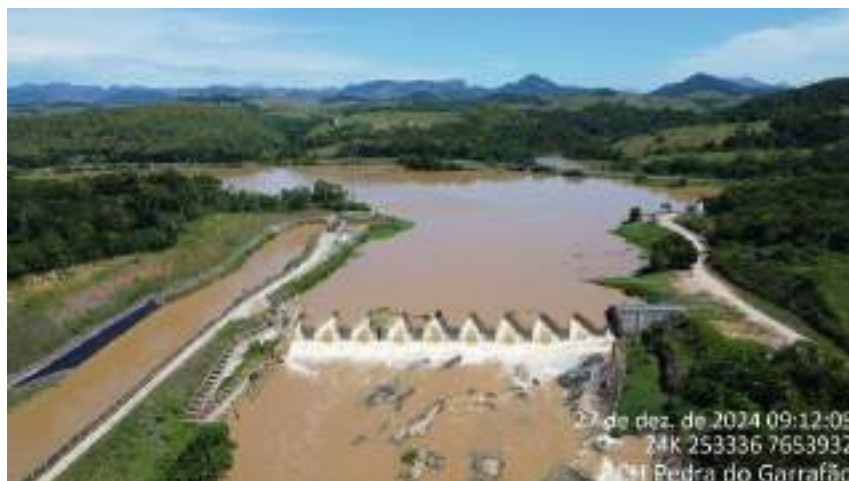
Foto 04 Vertedouro da soleira livre, Sistema de Transposição de Peixes do tipo Escada e vista parcial do Canal de adução e visão parcial durante vertimento. 27/12/2024.
