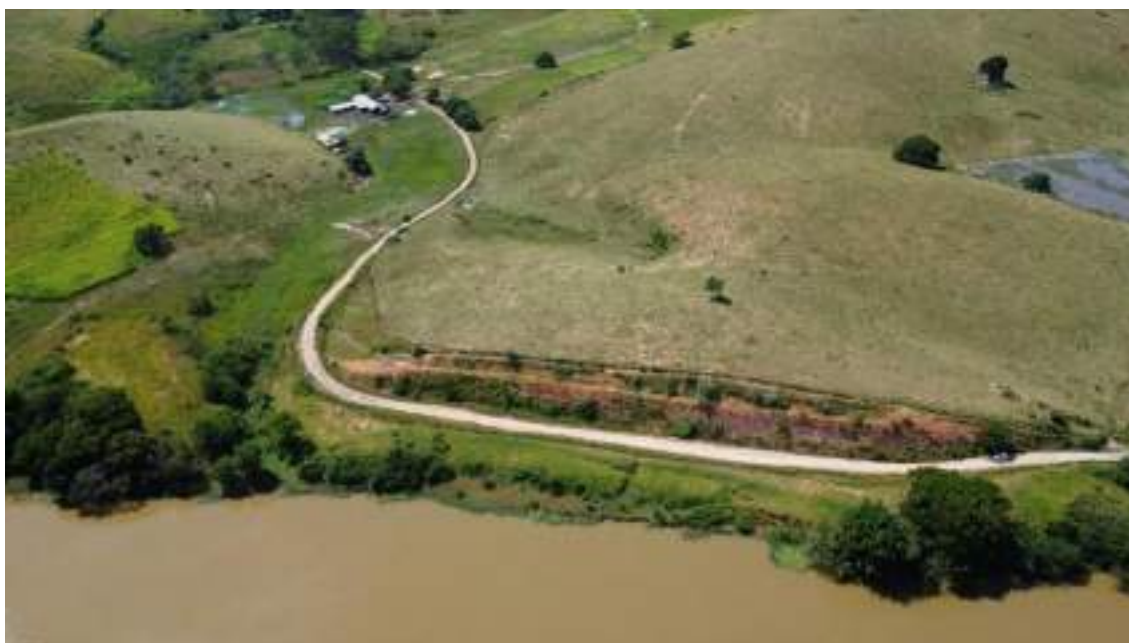
Foto 188 Visão Geral do Setor 1C – Área 5 em dezembro de 2024.
