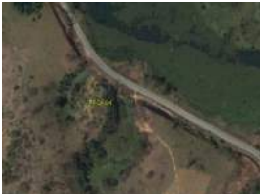
Foto 70 Visão geral do ponto PGF04 na PCH Pedra do Garrafão - 2018.
