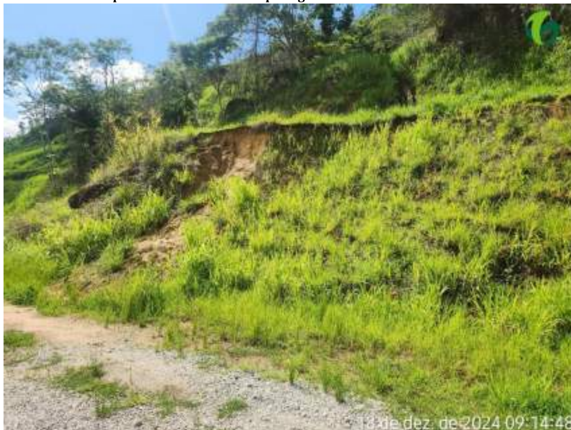
Foto 03 Visão Geral do ponto PIR23 na PCH Pirapetinga em dezembro de 2024
