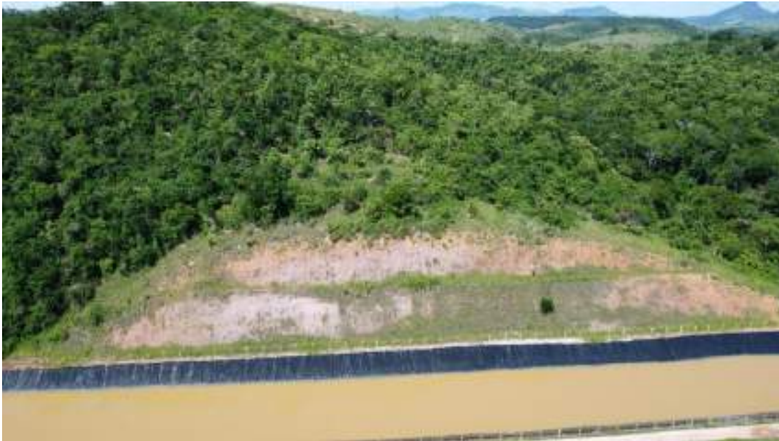
Foto 88 Visão Geral do ponto PIR17C na PCH Pedra do Garrafão em dezembro de 2024
