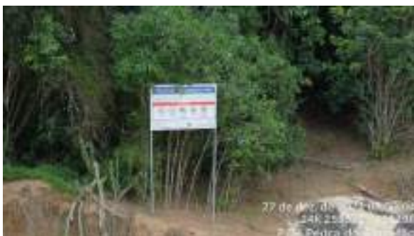
Foto 92 Nova placa de sinalização instalada no TVR da PCH Pedra do Garrafão.
