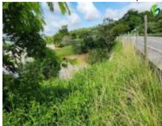
Foto 79 Visão geral do ponto PGF08/PGF15 na PCH Pedra do Garrafão - dezembro/2024.
