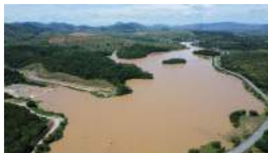
Foto 55 Visão geral do reservatório da PCH Pedra do Garrafão (Dez/24).
