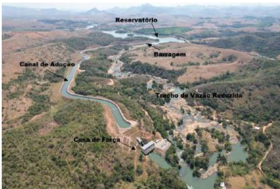
Figura 01 Imagem aérea da PCH Pedra do Garrafão
