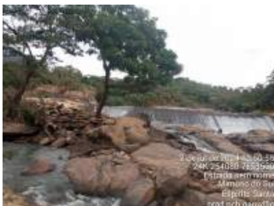
Foto 70 Visão geral da soleira 02 vertente na PCH Pedra do Garrafão (Jul/2024).
