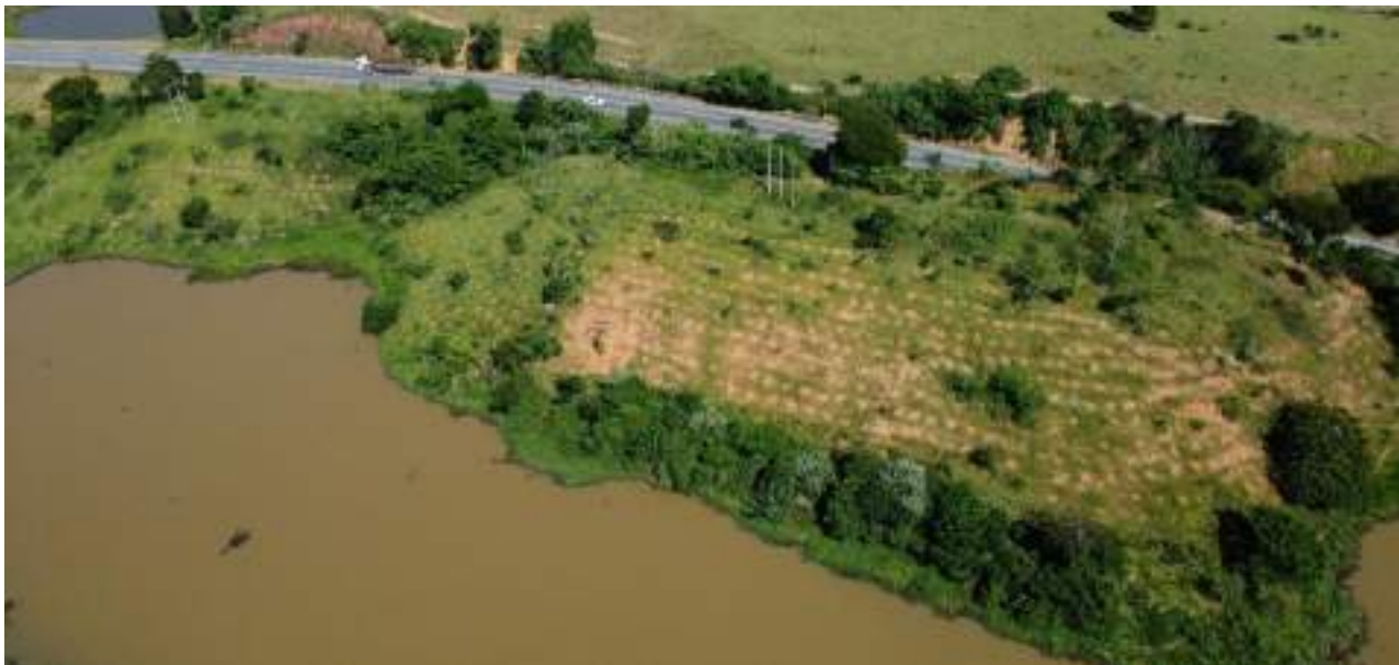
Foto 120 Visão Geral do Setor 1A – Área 01 plantado em novembro de 2024.
