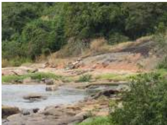
Foto 74 Visão geral do ponto PGF06 na PCH Pedra do Garrafão - 2018.
