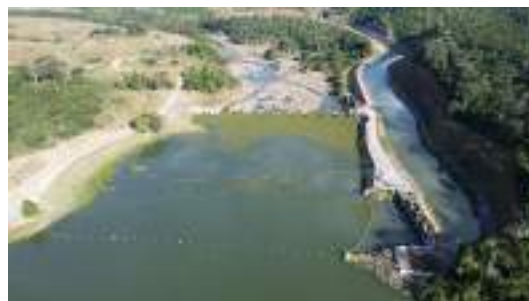
Foto 51 Início de formação de banco de macrófitas próximo ao barramento da PCH Pedra do Garrafão (ago/24).
