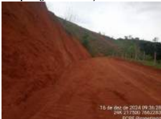
Foto 58 Visão geral de melhorias na base do acesso da chaminé de equilíbrio da PCH Pirapetinga – dezembro/2024.
