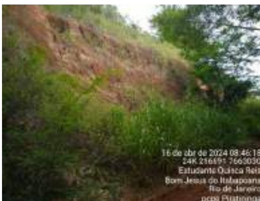
Foto 40 Visão geral do Ponto PIR11 na margem da estrada municipal Quincas Reis na PCH Pirapetinga – abril 2024.
