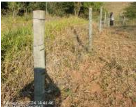
Foto 59 Manutenção do cercamento no setor 4 da PCH Pirapetinga. (ago/24).
