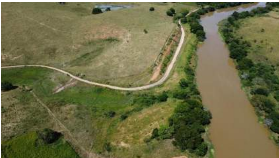
Foto 187 Visão Geral do Setor 1C – Área 5 em dezembro de 2024.
