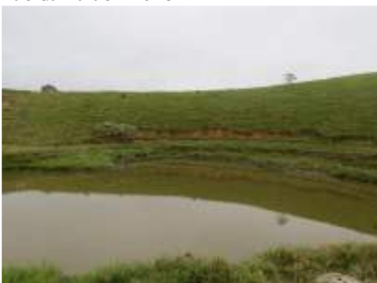
Foto 84 Visão geral do ponto PGF09 na PCH Pedra do Garrafão – 2018.
