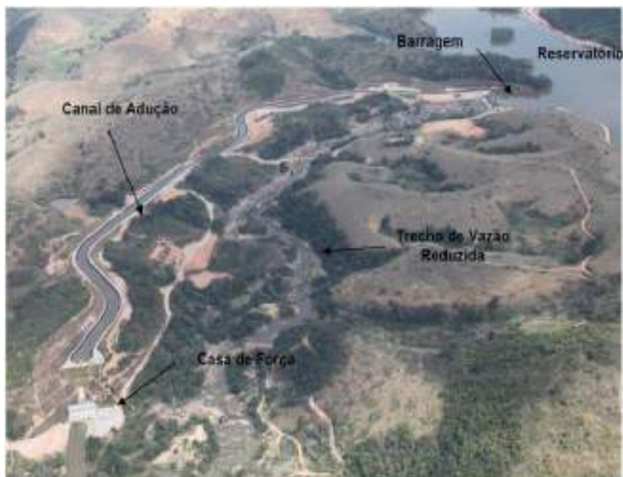
Foto 03 Imagem aérea da PCH Pedra do Garrafão
