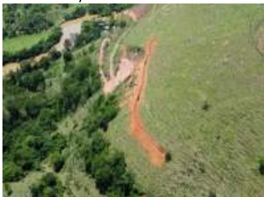
Foto 56 Visão geral das canaletas de crista instaladas no ponto PIR27 da PCH Pirapetinga – dezembro/2024.
