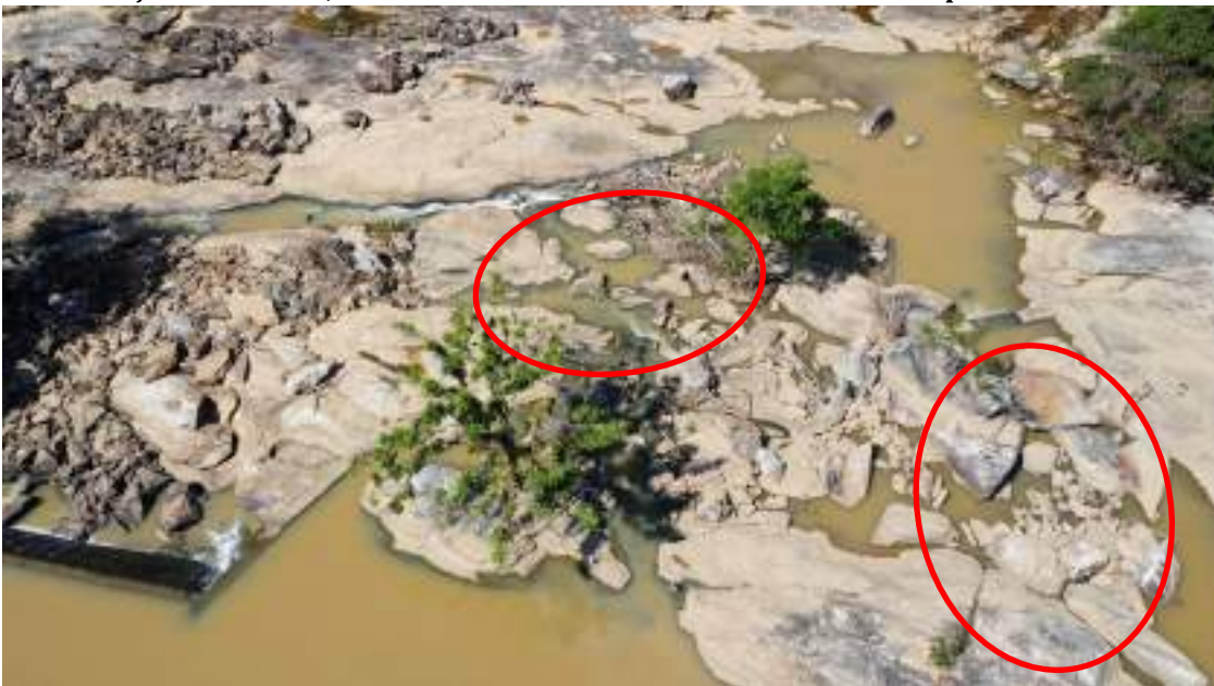
Foto 95 Região da soleira 2 no TVR da PCH Pedra do Garrafão, com o trecho obstruído pela movimentação das rochas, dificultando o deslocamento da ictiofauna no período de baixa vazão.
