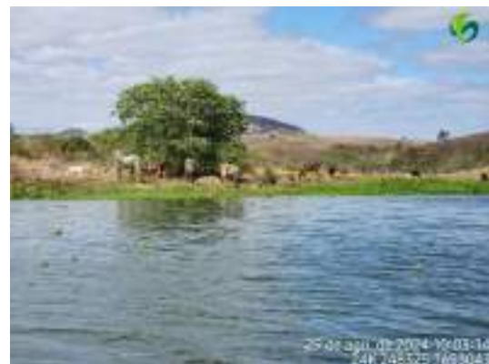
Foto 33 Presença de gado no setor 1C da PCH Pedra do Garrafão (Ago/2024).
