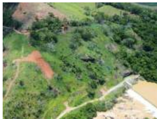
Foto 53 Visão geral do Ponto PIR29 sob o acesso do barramento na PCH Pirapetinga após retaludamento – dezembro/2024
