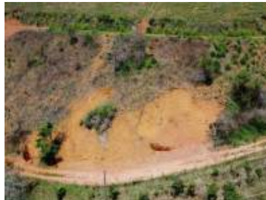
Foto 49 Visão geral do Ponto PIR26 no acesso da chaminé de equilíbrio da PCH Pirapetinga após retaludamento – dezembro/2024
