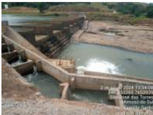
Foto 68 Visão geral da barragem, vazão sanitária e escada de peixe na PCH Pedra do Garrafão (Jul/2024).
