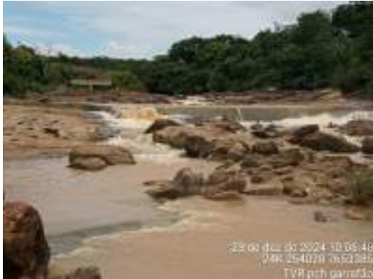
Foto 84 Visão geral da soleira 01 vertente na PCH Pedra do Garrafão (Dez/2024).
