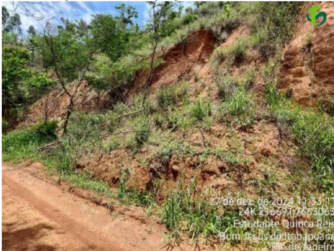
Foto 01 Visão Geral do ponto PIR11 na PCH Pirapetinga em dezembro de 2024
