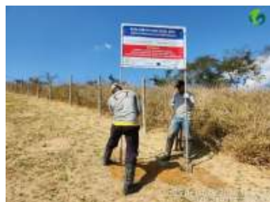
Foto 25 Instalação novas placas da APP da PCH Pedra do Garrafão (Setor 2).
