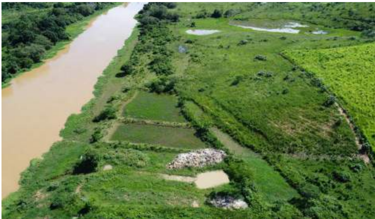
Foto 186 Visão Geral do Setor 1C – Área 4 em dezembro de 2024
