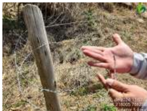
Foto 11 Cerca danificada no Setor 5 (área 1), na PCH Pirapetinga.
