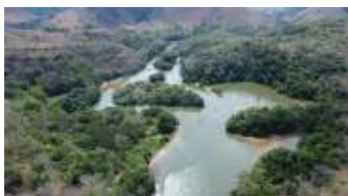
Foto 16 Visão geral do reservatório da PCH Pirapetinga em setembro/2024.
