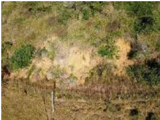
Foto 48 Visão geral do Ponto PIR26 no acesso da chaminé de equilíbrio da PCH Pirapetinga – junho/2024.
