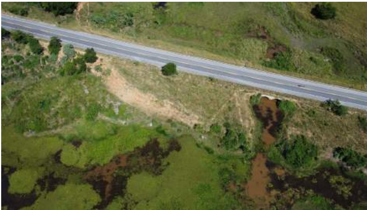
Foto 121 Visão Geral do Setor 1A - Área 02 em dezembro de 2024.
