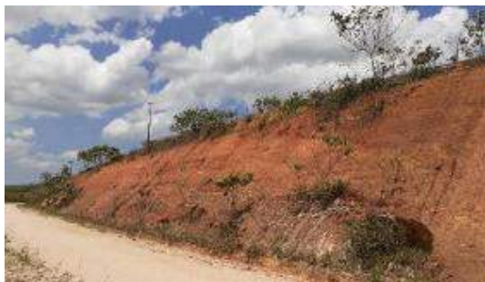
Foto 92 Visão geral do ponto PGF13 na PCH Pedra do Garrafão em 2019.
