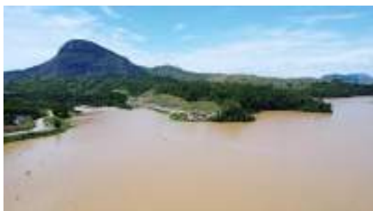
Foto 54 Visão geral do reservatório da PCH Pedra do Garrafão (Nov/24).
