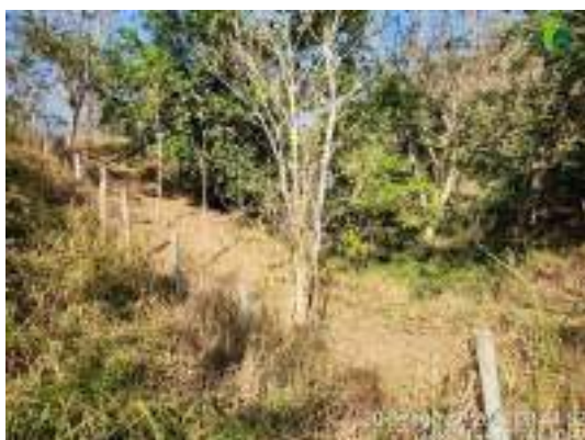
Foto 61 Vistoria no cercamento do setor 4 da PCH Pirapetinga. (ago/24).
