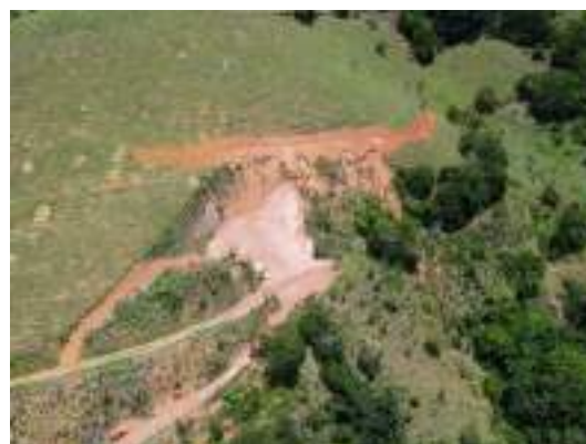
Foto 51 Visão geral do Ponto PIR27 no acesso da chaminé de equilíbrio da PCH Pirapetinga após retaludamento – dezembro/2024
