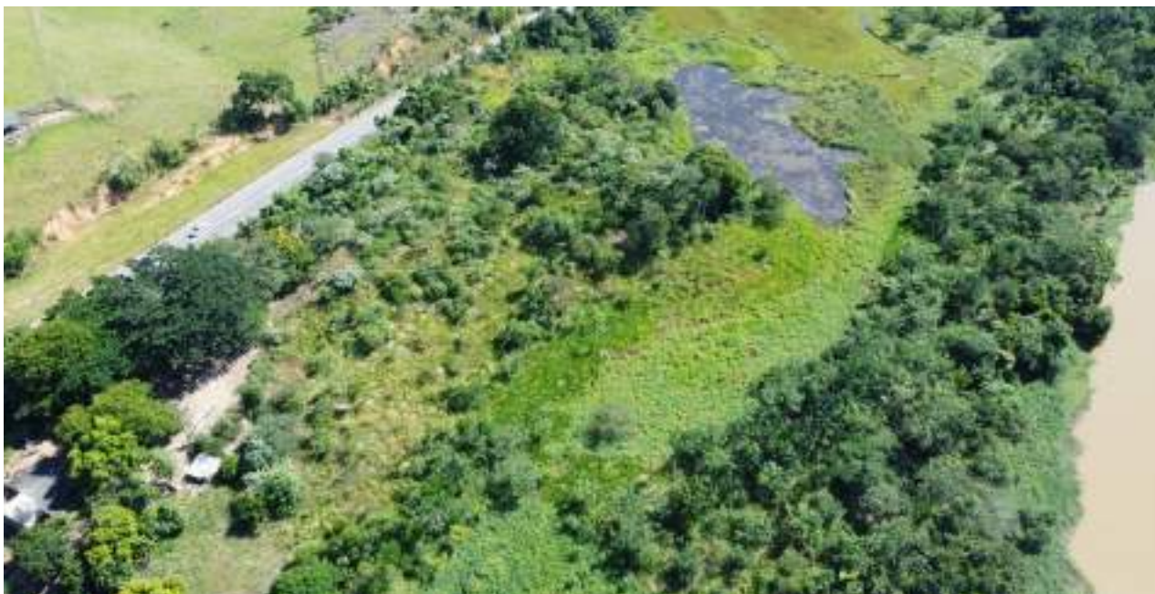
Foto 141 Visão Geral do Setor 1A - Área 06 em dezembro de 2024.
