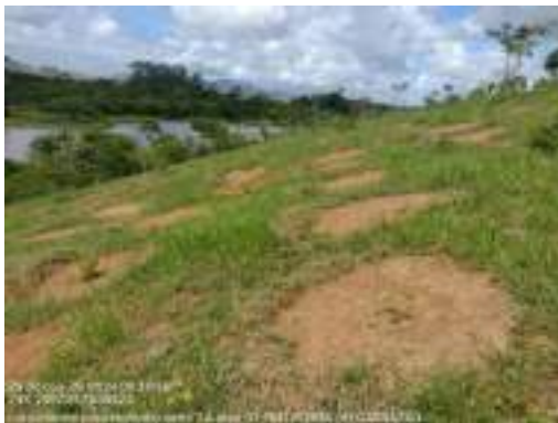
Foto 19 Coroamento no setor 1A na PCH Pedra Garrafão.
