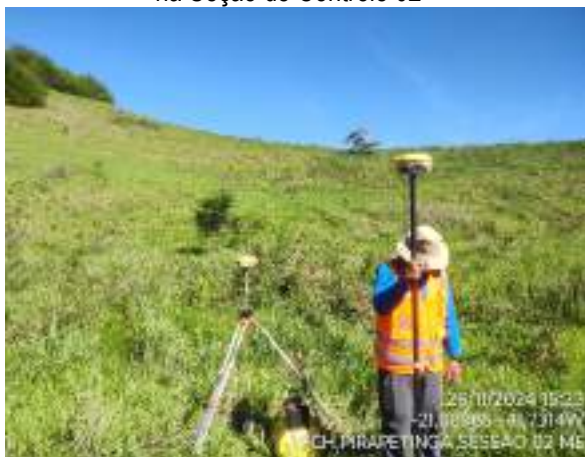
Registro fotográfico 3-7 – Levantamento com RTK na Seção de Controle 02
