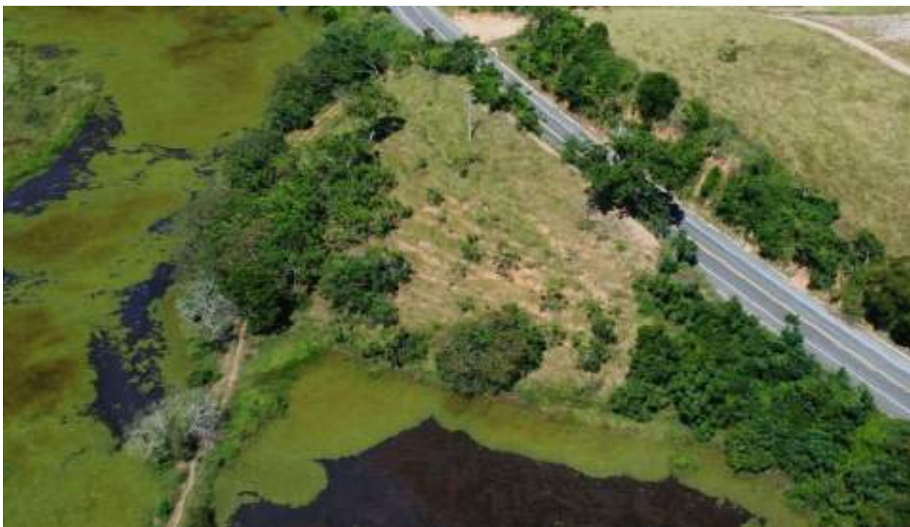
Foto 136 Visão Geral do Setor 1A – Área 05 em dezembro de 2024.
