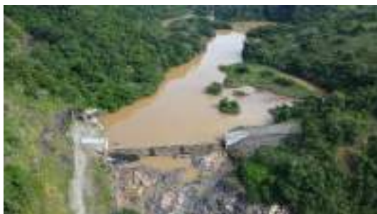
Foto 01 Vista do barramento da PCH Pirapetinga.
