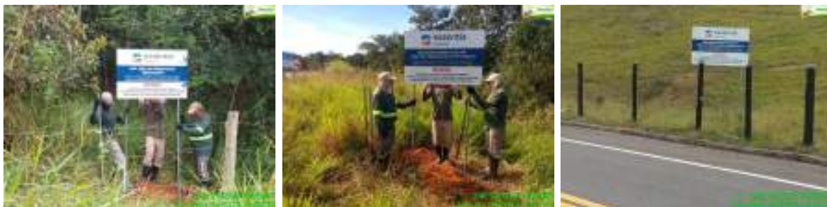
Composição 13: Instalação de placas de sinalização de APP, com proibições cabíveis em legislação.
