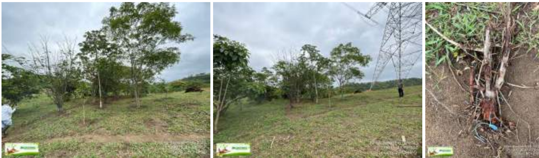
Composição 18: Instalação de torre de transmissão em local de UA, com desbaste de algumas árvores anteriormente monitoradas.
