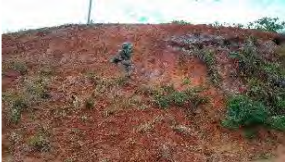
Foto 20 Manutenção do PGF13 (janeiro/2023) na PCH Pedra do Garrafão. Microsemeadura com mix de sementes.
