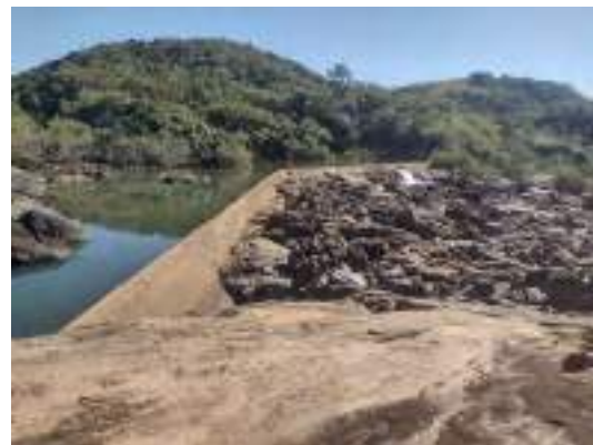
Foto 60 Visão geral da soleira da PCH Pirapetinga em julho/2023.
