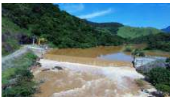
Foto 01 Vista do barramento da PCH Pirapetinga.
