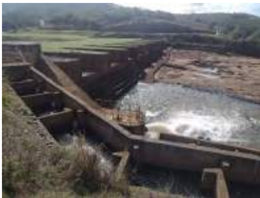
Foto 79 Visão geral da barragem, vazão sanitária e escada de peixe na PCH Pedra do Garrafão em julho/2023.
