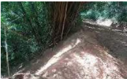
Foto 30 Resultado da manutenção do PIR10 (fevereiro/2023) na PCH Pirapetinga. Reconformação do foco com terra, e melhoria no sistema de drenagem.
