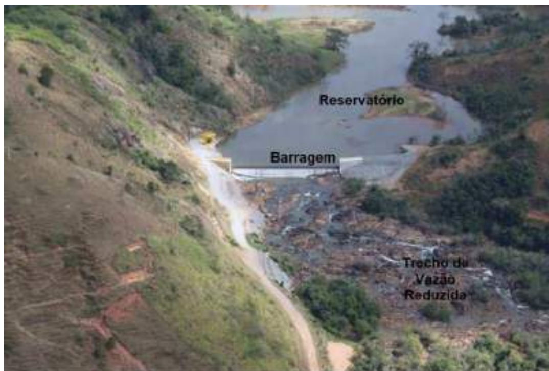
Figura 02 Imagem aérea da PCH Pirapetinga
