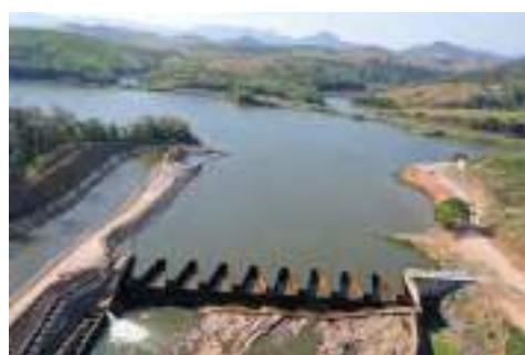
Foto 02 Vista do barramento da PCH Pedra do Garrafão.
