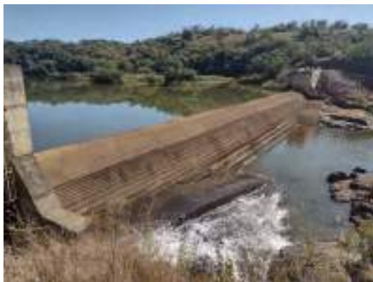
Foto 59 Barramento da PCH Pirapetinga em julho/2023.
