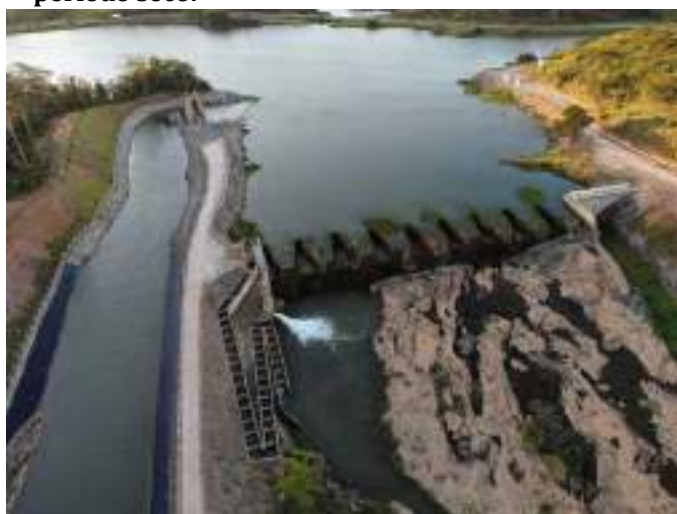
Foto 06 Vista aérea do barramento, do Sistema de Transposição de Peixes do tipo Escada e vista parcial do Canal de adução, situados na PCH Pedra do Garrafão.
