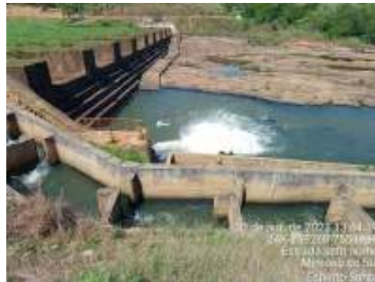
Foto 88 Visão geral da barragem, vazão sanitária e escada de peixe na PCH Pedra do Garrafão em outubro/2023.
