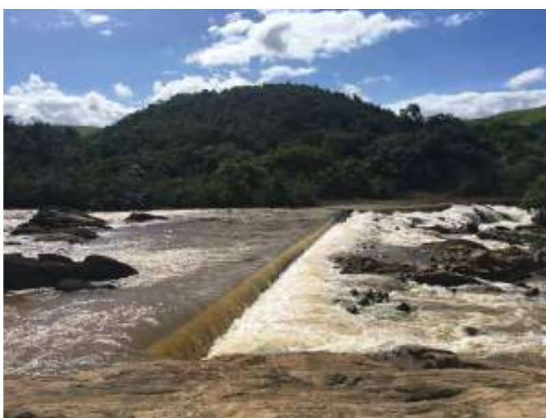
Foto 02 Visão da soleira vertente localizada no TVR da PCH Pirapetinga.
