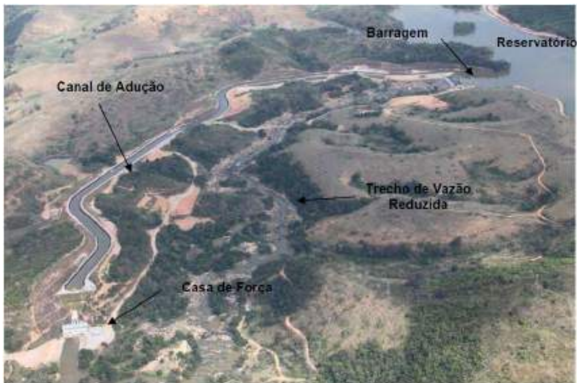
Figura 01 Imagem aérea da PCH Pedra do Garrafão
