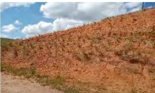
Foto 24 Resultado da manutenção do PGF13 (abril/2023) na PCH Pedra do Garrafão. Microsemeadura com sementes de leguminosas.
