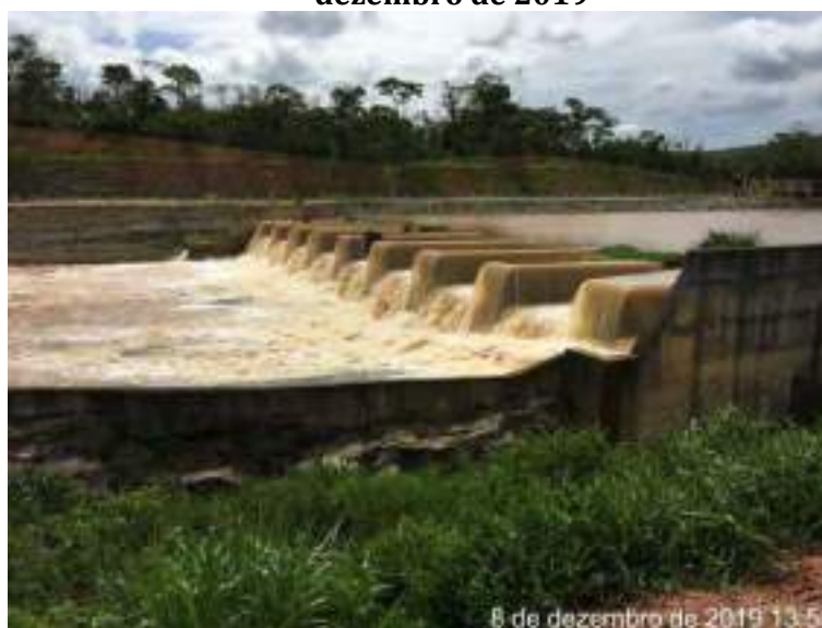
Figura 51 Barramento da PCH Pedra do Garrafão com intenso vertimento de água em dezembro de 2019
