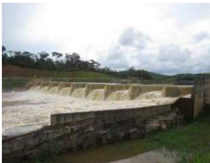
Foto 04 Vertedouro da soleira livre e visão parcial durante vertimento.
