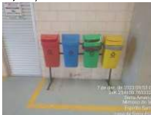
Foto 15 Inspeção coletores na praça de máquinas da PCH Pedra do Garrafão.
