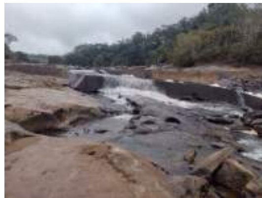
Foto 80 Visão geral da soleira 01 vertente na PCH Pedra do Garrafão em julho/2023.
